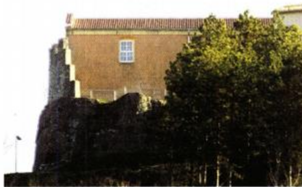
Crkva se nalazi na najvišoj koti gradskih zidina
