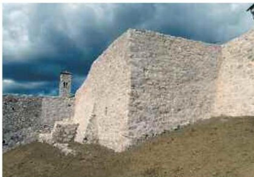
i uređena kruna zida, trošni dijelovi zida ojačani su injektiranjem, ugrađena su samobušuća sidra i na kraju je prije nasipavanja ugrađen tkani geotekstil kako bi se osigurao stabilitet zida uslijed opterećenja nasipa iza zida.
